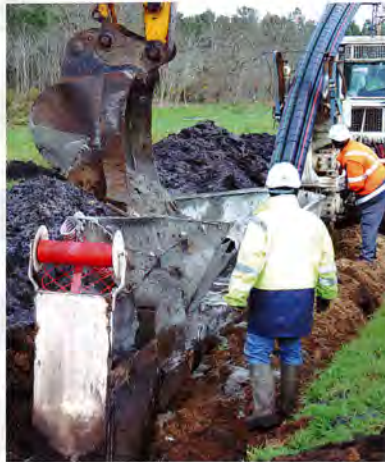
Disposés en tréfle au fond de la tranchée, les câbles sont recouverts de remblai liquide, puis la tranchée est comblée avec la terre excavée. Un grillage de plastique rouge inséré dans la tranchée signale la présence de la ligne haute tension.
